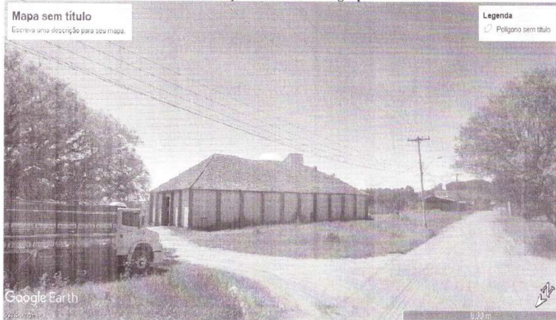
Figura 05 - Pavilhão Industrial 06 Parque dos Olivais – Agropecuária Didoné
