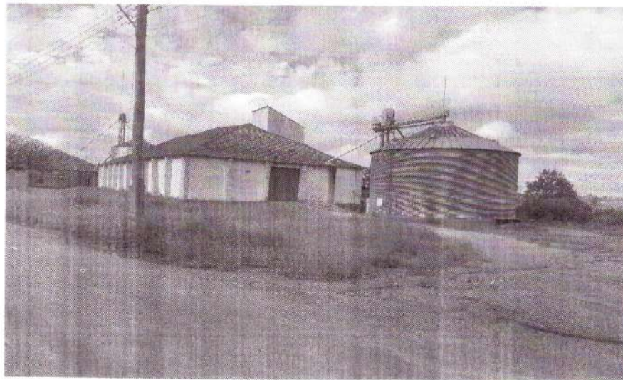
Figura 08 - Pavilhão Industrial 06 Parque dos Olivais – Agropecuária Didoné
